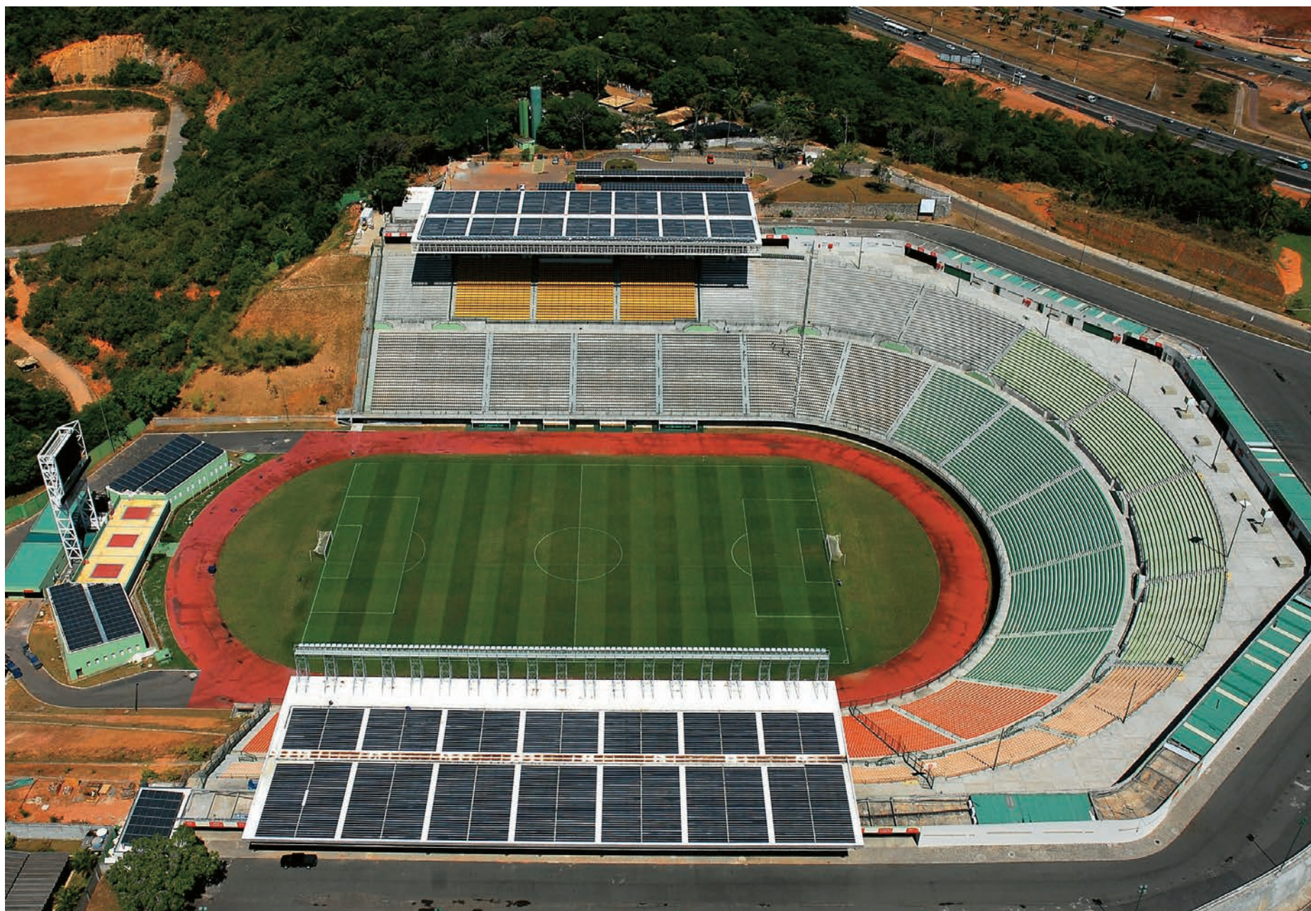
FIGURA 4.7 » Usina Solar do Estádio de Pituáçu, com capacidade instalada de 404 kW e composta por 2.292 módulos fotovoltaicos.
