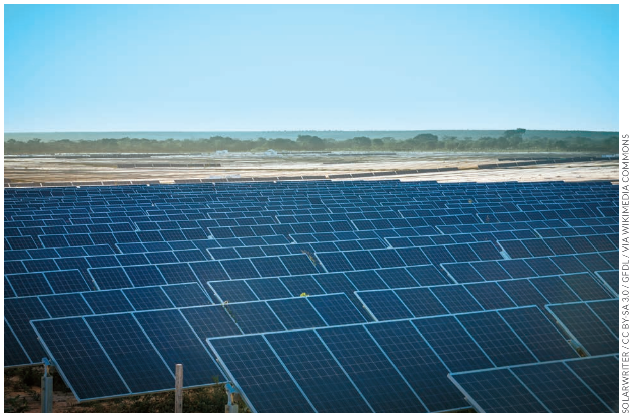
FIGURA 4.6 » Parque Solar Ituverava, em Tabocas do Brejo Velho, composto por cerca de 850 mil painéis solares distribuídos em uma área de 546 hectares. Quando estiver em plena operação, o parque será capaz de produzir mais de 550 GWh. Ituverava é, atualmente, o segundo maior parque solar em operação da América do Sul*.
