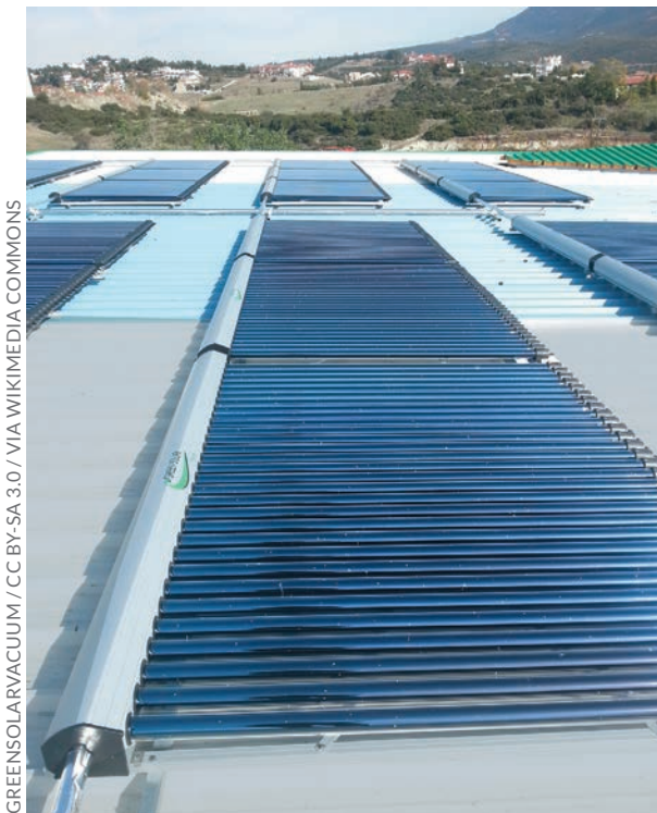
FIGURA 4.3 » Placas solares térmicas com tubos a vácuo (Green Solar).
